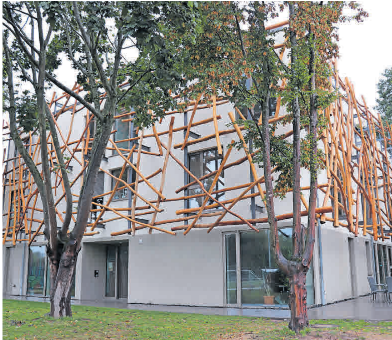
Unverkennbarer Nestcharakter: Faxe Müller aus Jossgrund hat die Fassade des „Schwanennests“ mit einer außergewöhnlichen Konstruktion aus Robinienholz ummantelt. FOTO: SCHMIDT
